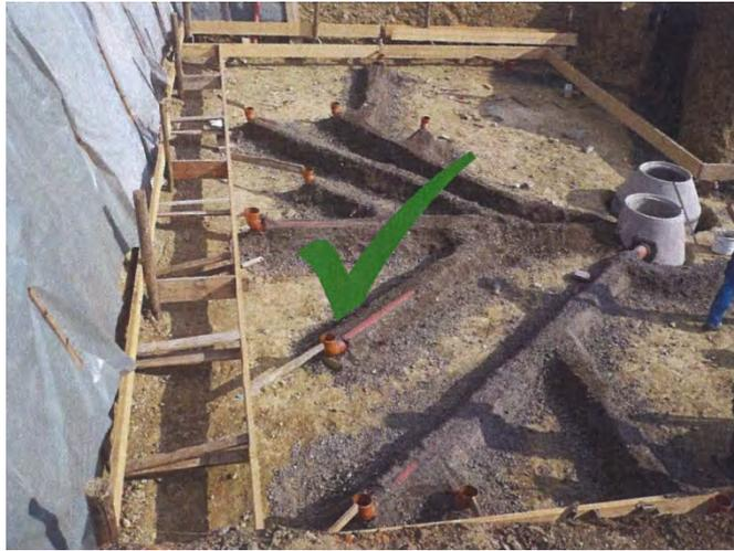
Dans le cas de condition de charges particulières et des conditions de pose spécifique, on effectuera un calcul statique selon la norme SIA 190, ceci afin de déterminer si des mesures surclassant les caractéristiques du profil U4/V4 sont nécessaires (par exemple pose d'armature dans le béton d'enrobage).
