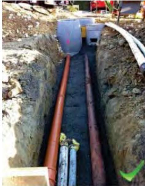
Canalisations AVEC assise bétonné
