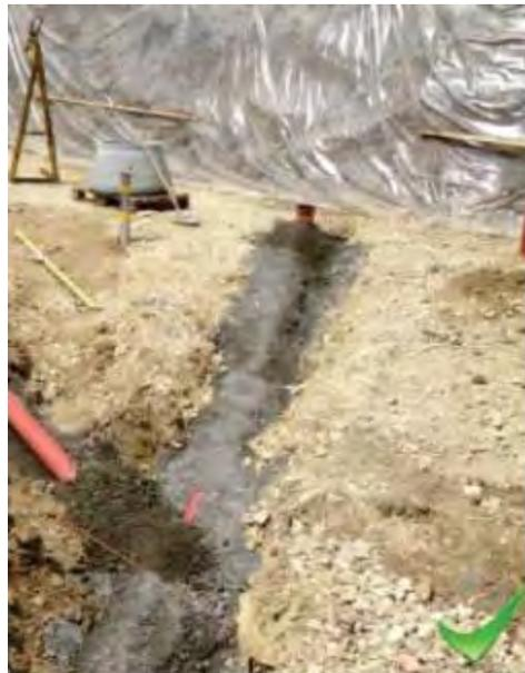
Canalisation en cours de bétonnage
